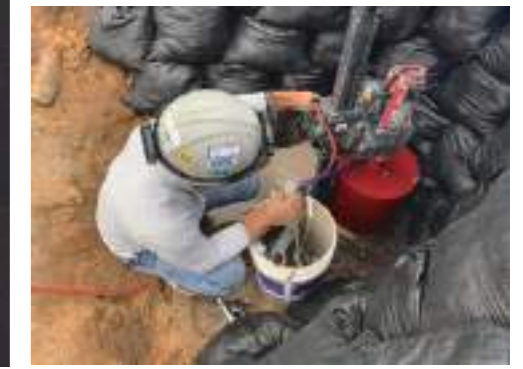
監房天井部へのφ350mm コアリングの様子
