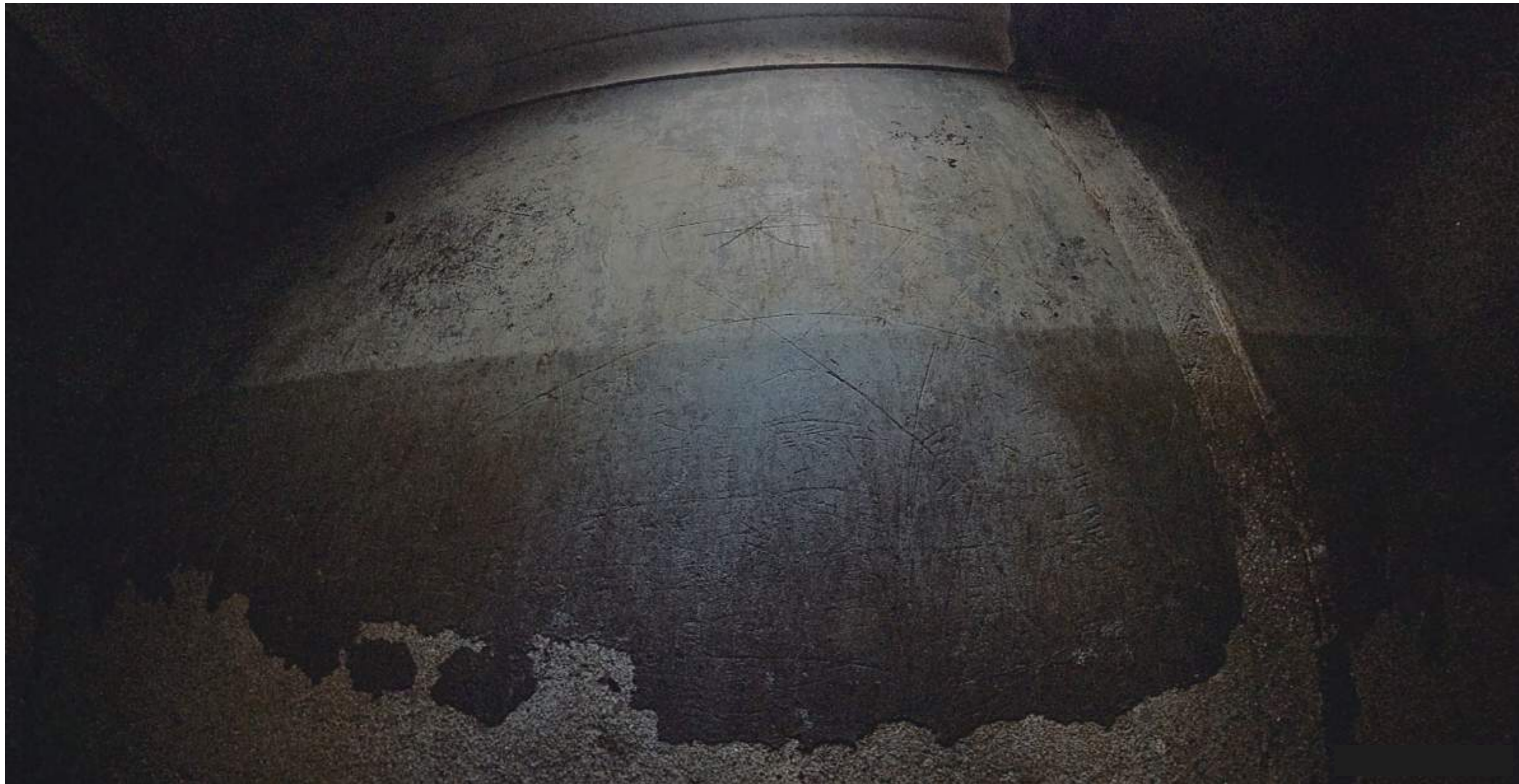
西面 (海側) 落書き (漆喰を削り刻まれた文字)
