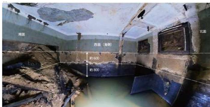
雨水と土砂の流入・滞留が確認できる。南面の木製格子が壊れ、土砂とともに内部に流入している。
