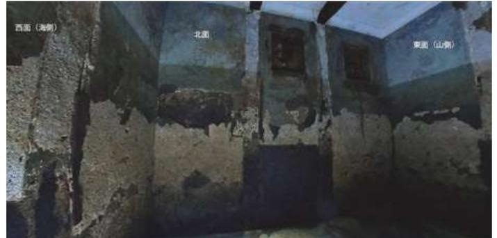
雨水の流入と滞留が確認できるが、土砂の流入は確認できない。かつて存在した間仕切りの痕跡が確認できる。
