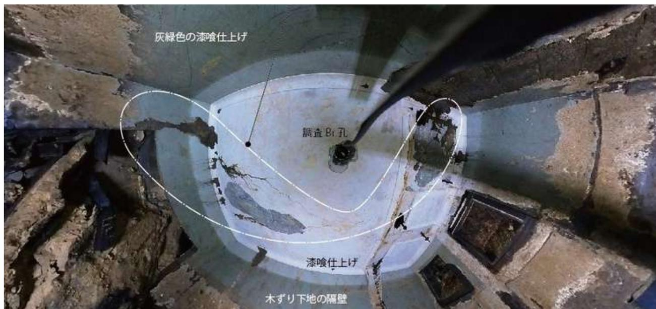
天井。壁面から天井にかけてクラック (白囲み内) が走る。上部の土砂の荷重の影響と考えられる。
