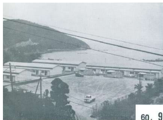
写真 46 整備が進む望ヶ丘団地
