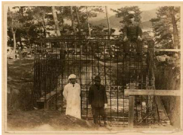
写真 19 納骨堂建設中
