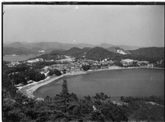
写真 14 配水池から愛生園を望む
