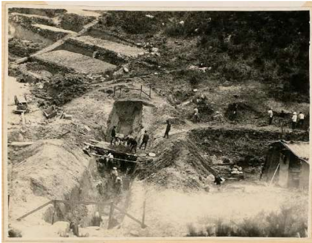
写真 53 造成中の相愛溜池
