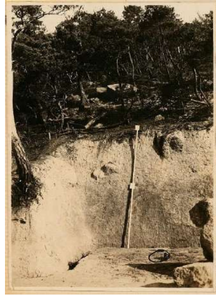
写真 54 造成中の相愛溜池
