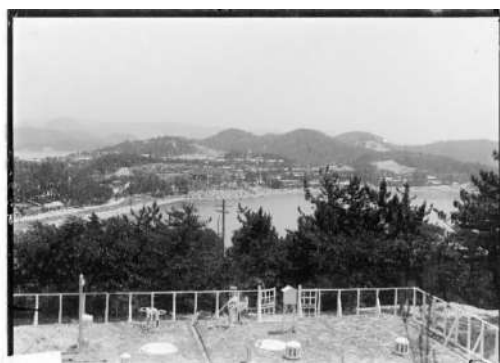
写真 01 配水池から愛生園を望む
