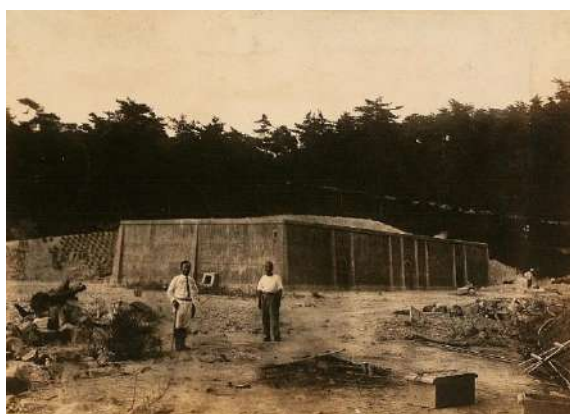
写真 26 監房（建築直後か）
