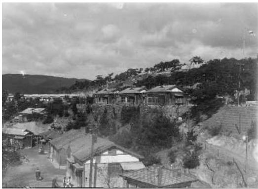
写真 59 礼拝堂 2 階から売店、十坪住宅、恵の鐘を望む
