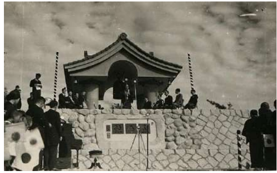
写真 58 恵の鐘竣工式
