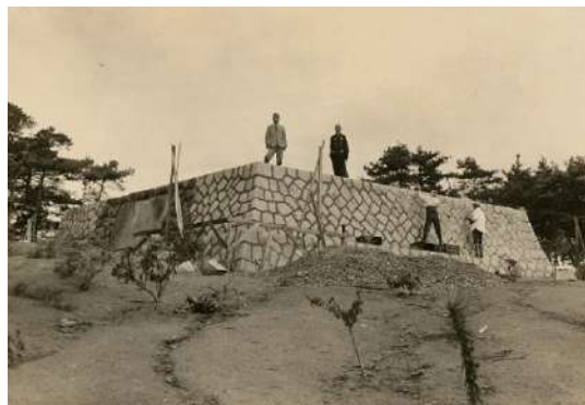
写真 56 恵の鐘基礎の造成
