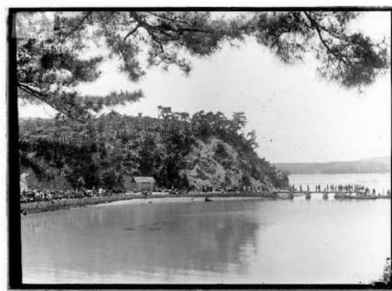
写真 23 患者収容栈橋（木製橋桁）
