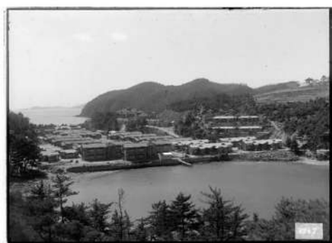
写真 34 現在の天理教上（報国農園入口） 附近から日出地区患者住宅を望む
