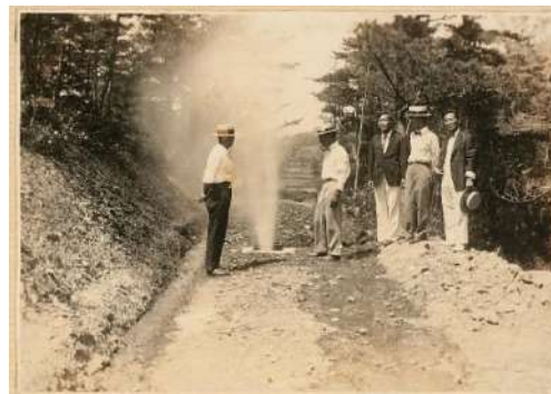
写真 04 園内上水道開通
