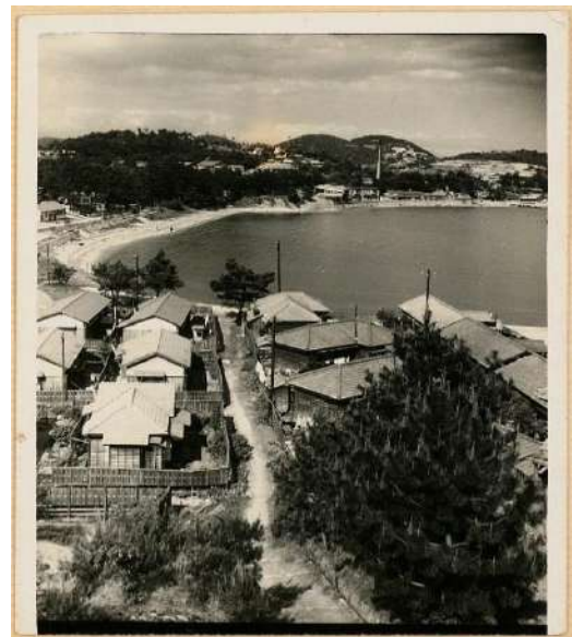
写真 06 官舎と配水地をつなぐ階段から官舎と 愛生園を望む
