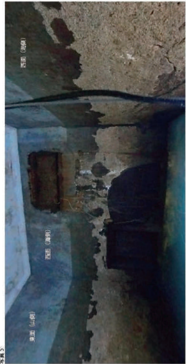
写真6 壁面の剥離を
