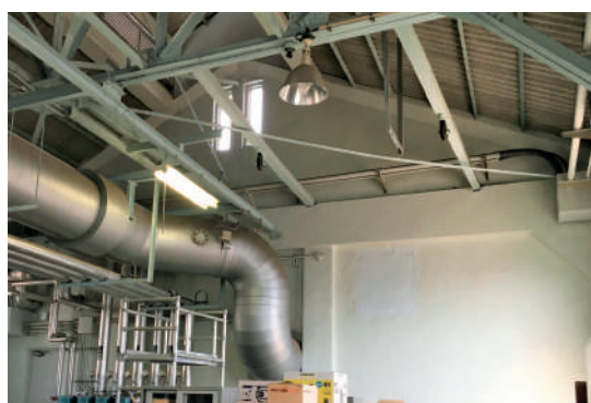
石炭燃料時代の滑車と壁面に残る旧煙突 への排気口跡（2021年8月撮影）
