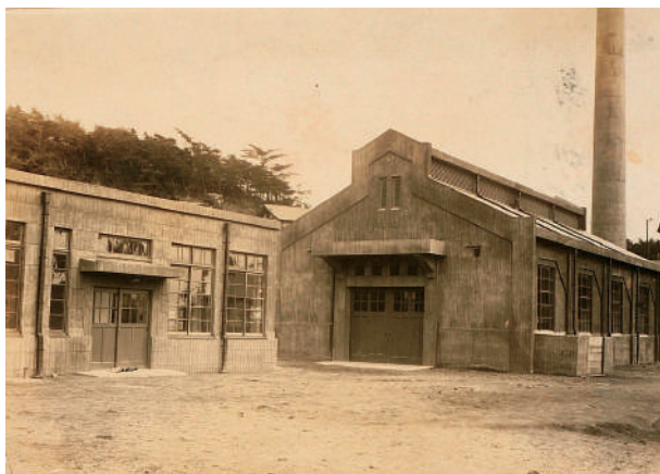
撮影時期不詳（竣工直後か。左は消毒室）
