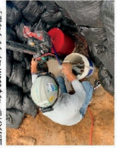
監査天井部へのφ350mm コアリングの様子
