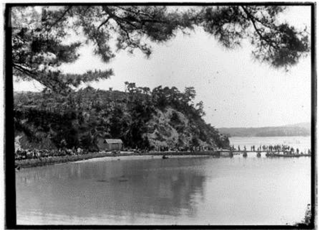
患者収容棧橋（木製橋桁）
