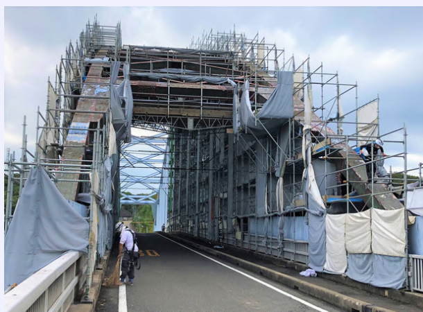
古い塗装を剥がし、下地が見える状態（9月）
