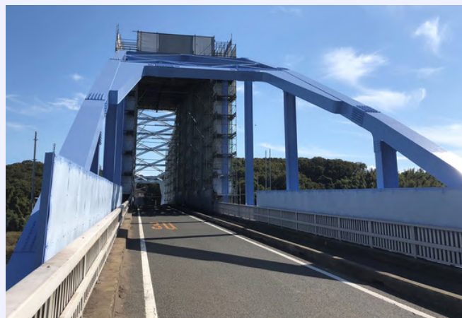
一部の塗装の完了後（10月）
