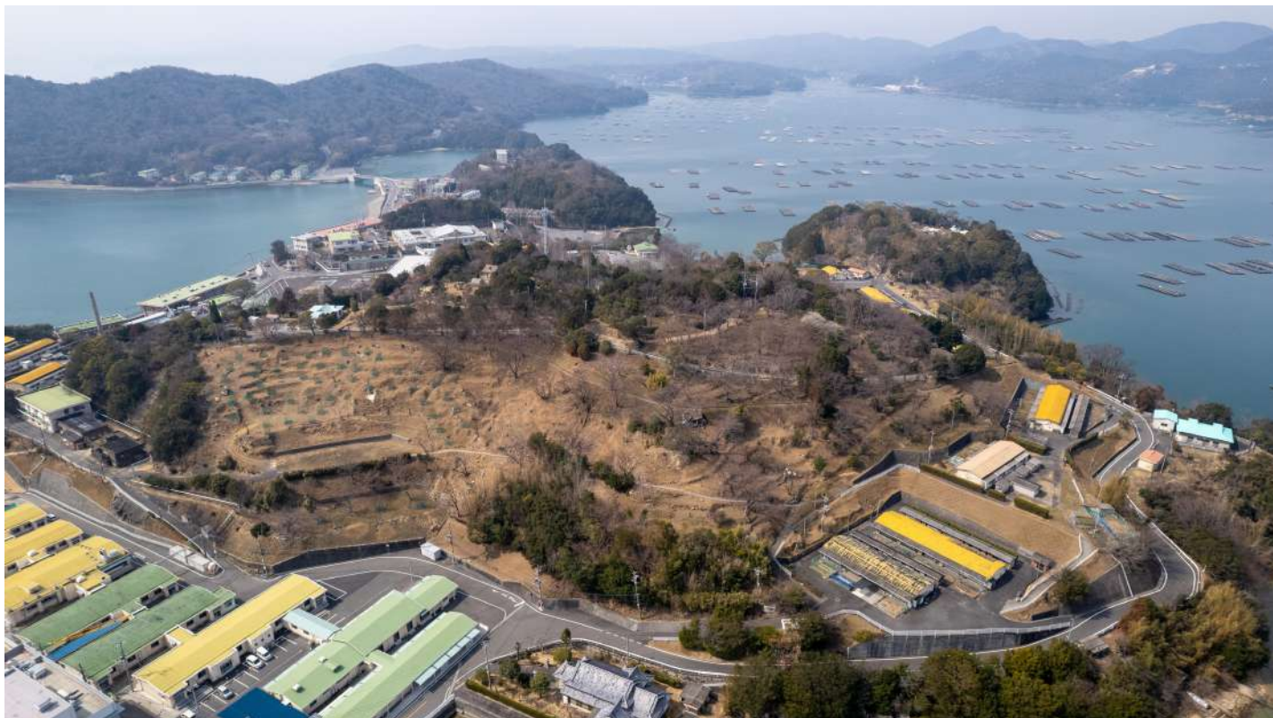
光ヶ丘東側斜面の農区跡。段畑の跡には交流の証であるサクラが植樹されている。
