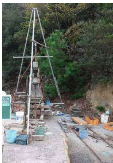
Bor-No.1ボーリング調査
