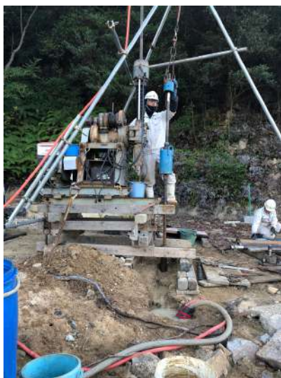
Bor-No.2ボーリング調査
