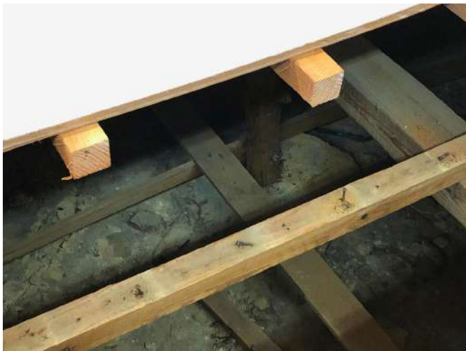
床下調査。新築時と推定される床組と基礎を確認。
