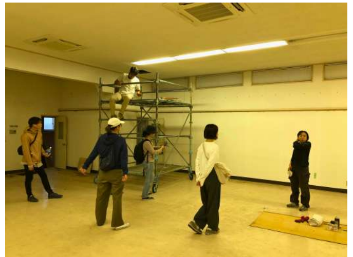
ローリングタワーを用いた屋根裏調査
