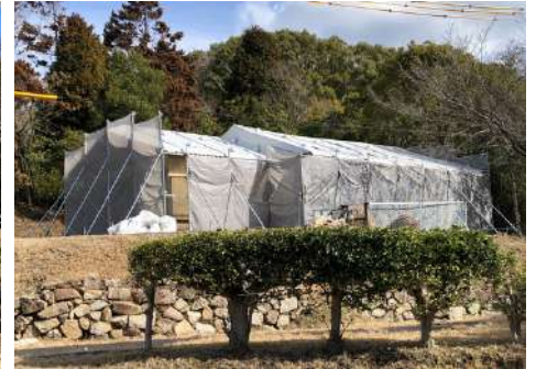
措置施工完了（現在）
