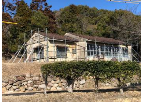
単管を設置した状態
