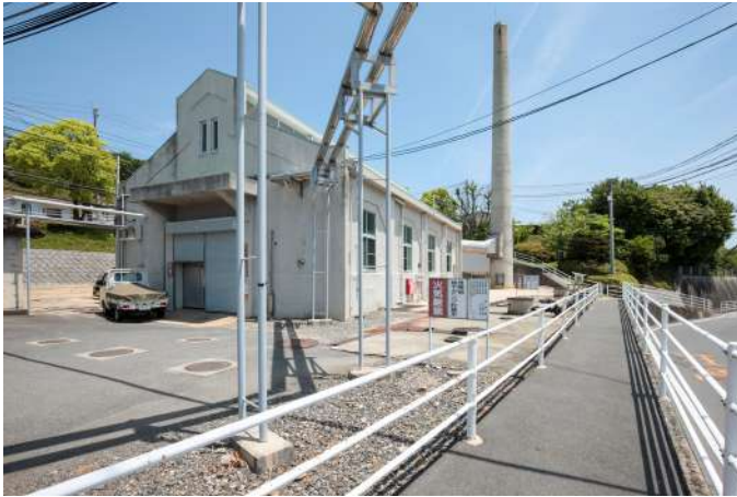
汽缶場（ボイラー棟）（1930年築）
