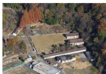
(写真12) 邑久高等学校旧新良田教室
