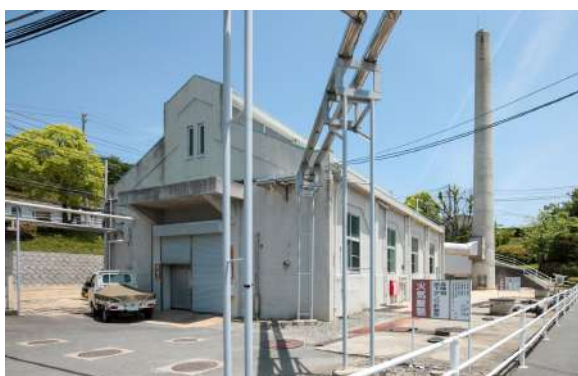
汽缶場（ボイラー棟）（1930年築）
