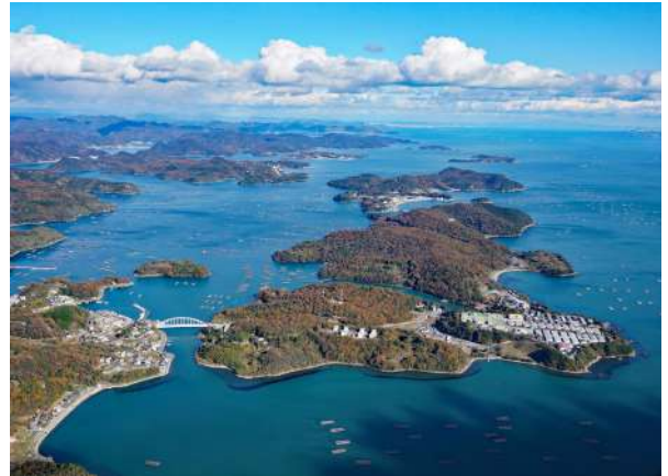
(写真01) 長島（中央）と本土をつなぐ邑久長島大橋
