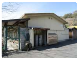
建造物（一般舎）
