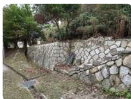
工作物（石積擁壁）
